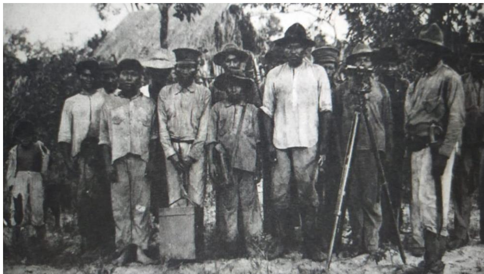
Figura 2- Trabalhadores das etnias Guarani Kaiowá e Terena na construção das linhas telegráficas entre Dourados e Ponta Porã, em 1948.
