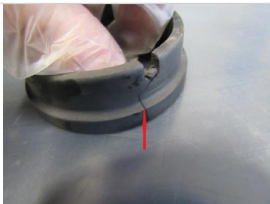
Figura 13 - Face estacionária danificada por torção. Fonte: Próprio autor
