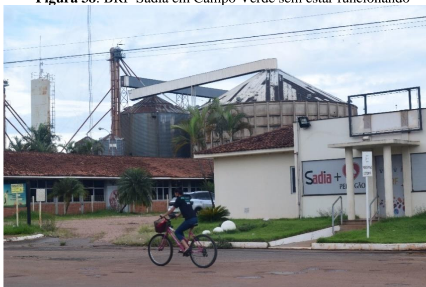
Figura 38: BRF-Sadia em Campo Verde sem estar funcionando
