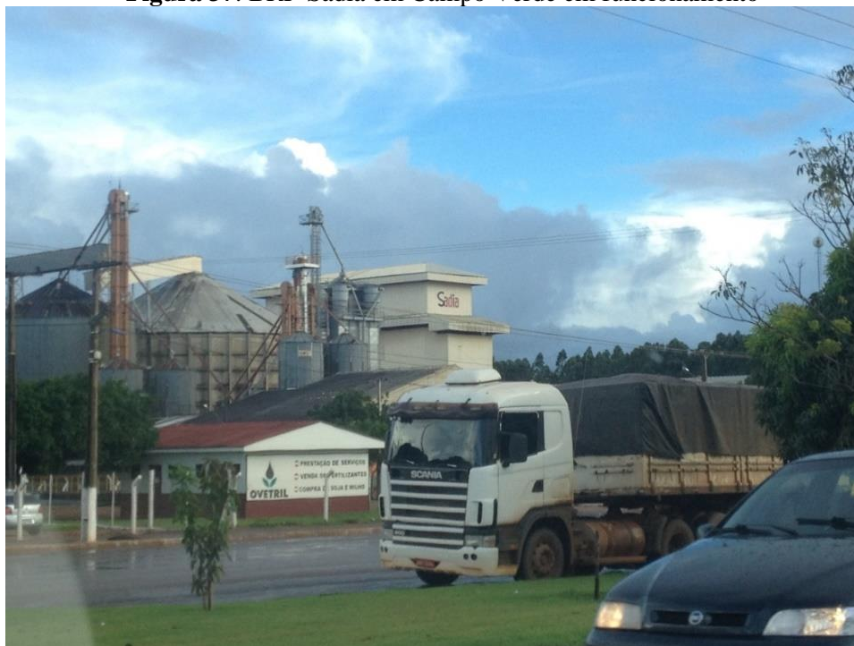
Figura 37: BRF-Sadia em Campo Verde em funcionamento
