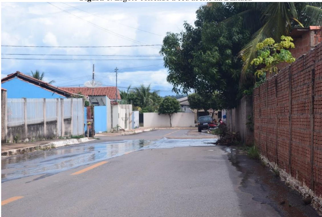
Figura 6: Esgoto correndo a céu aberto na Baixada
