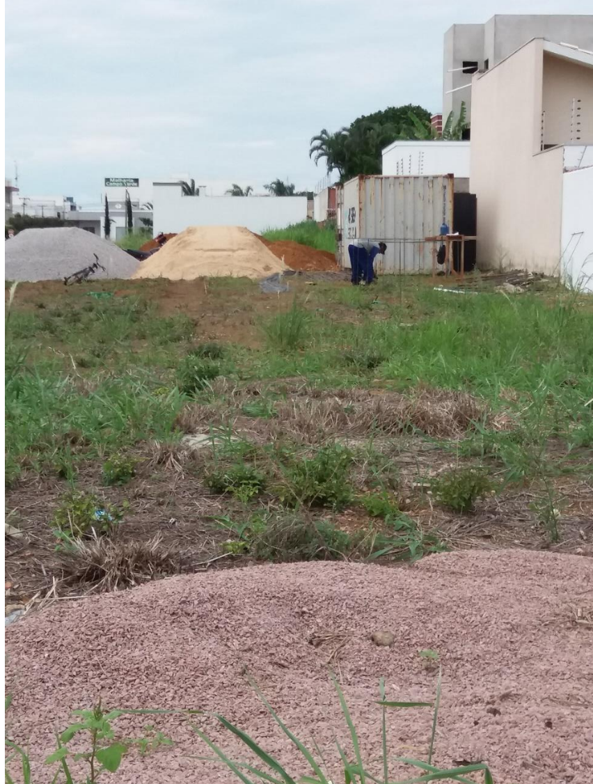
Figura 55: Homem negro trabalhando em uma construção no bairro Campo Real
