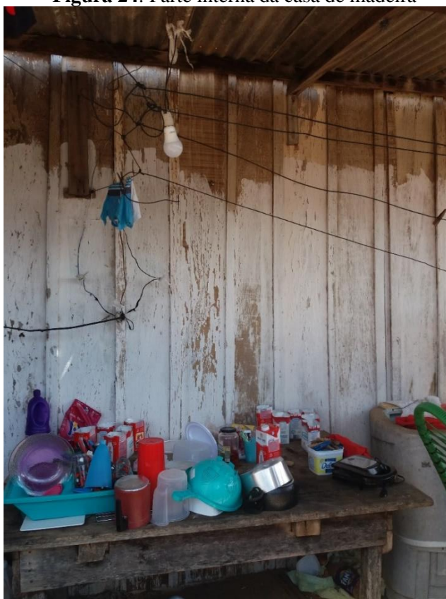
Figura 24: Parte interna da casa de madeira
