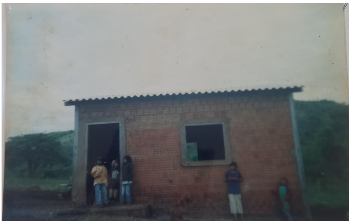
Figura 3 – Escola de Bacuri reformada
