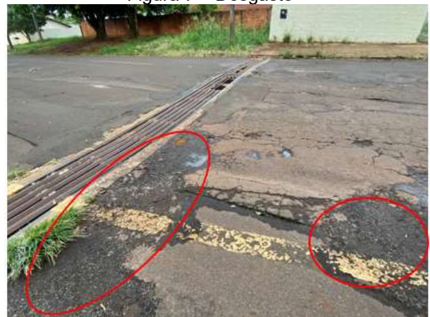
Figura 7 – Desgaste
