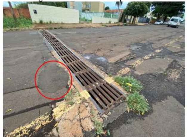
Figura 11 – Remendo superficial
