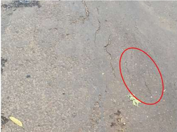
Figura 8 – Fissuras
