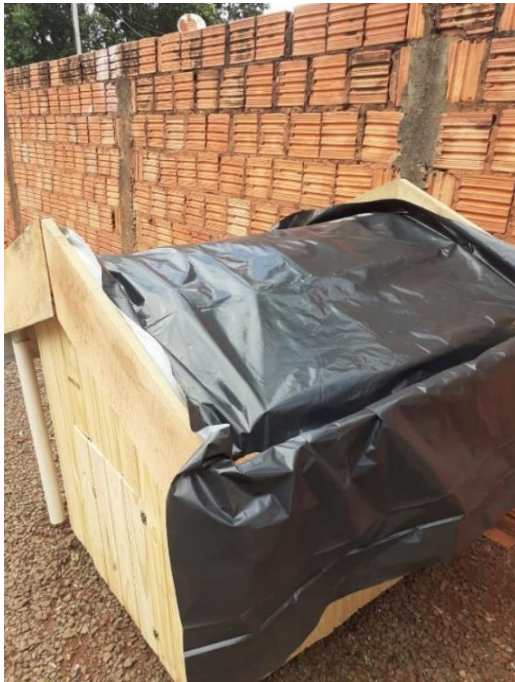
Figura 6 – Camada de impermeabilização com lona
