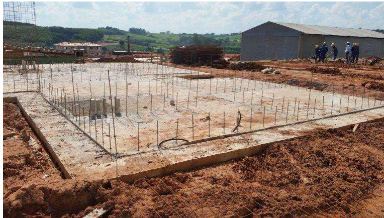
Figura 2 – Fundação do tipo Radier
