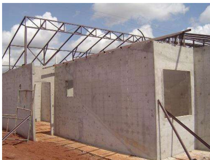
Figura 1 – Parede de Concreto moldado in loco
