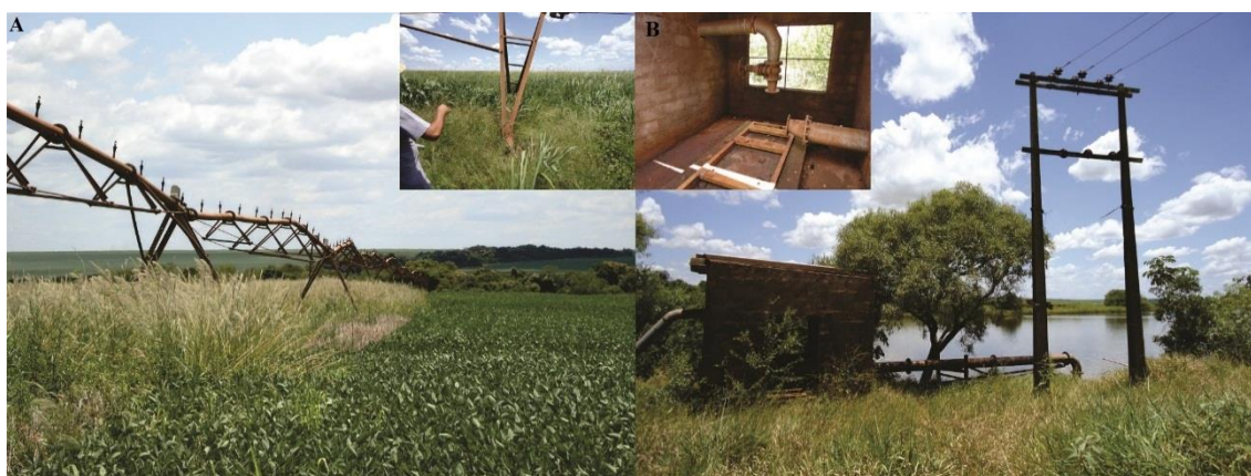
FIGURA 25. Fotos de estrutura de pivô central sucateado, sendo: a) detalhe torre sem o jogo de rodas; b) local onde deveria estar a instalação do sistema de bombeamento; e o transformador para funcionamento do conjunto moto-bomba.
