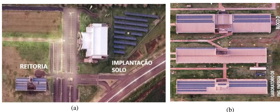
Figura 3- (a) Vista superior dos sistemas instalados no telhado da reitora e no solo; (b) Instalações em telhado no bloco D e laboratório de Engenharia de Energia. Fonte: Sairus Engenharia.
