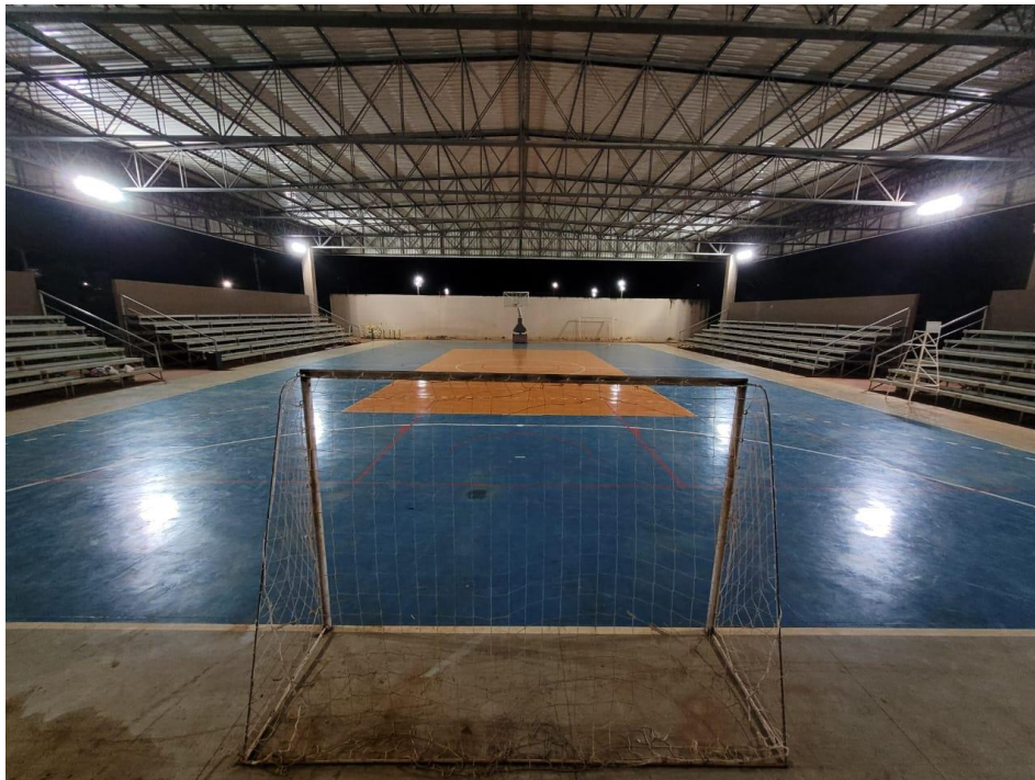
Figura 11 – Iluminação atual da quadra poliesportiva - UFGD
