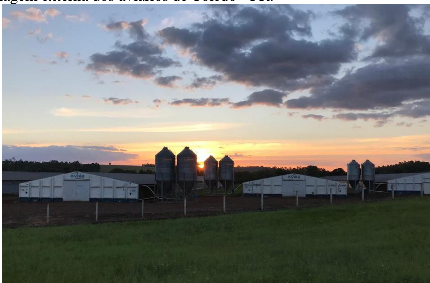
Figura 6 - Imagem externa dos aviários de Toledo - PR.
