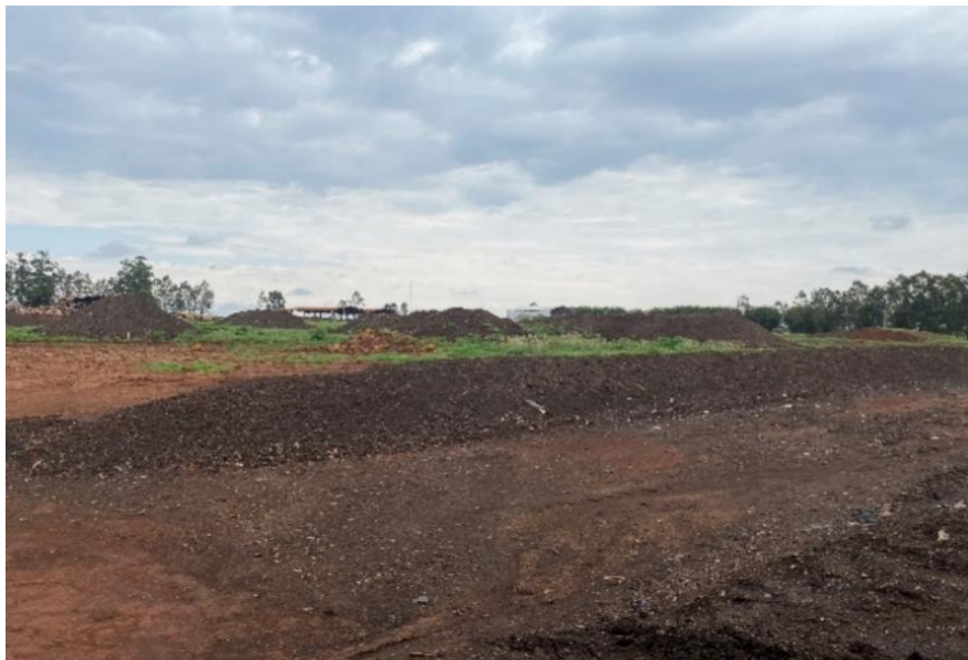
Figura 7. Estrutura das leiras em funcionamento.
