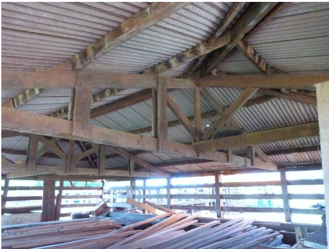
Figura 12 – Telhado em madeira produzido pela equipe, anos 1960 a 1965
