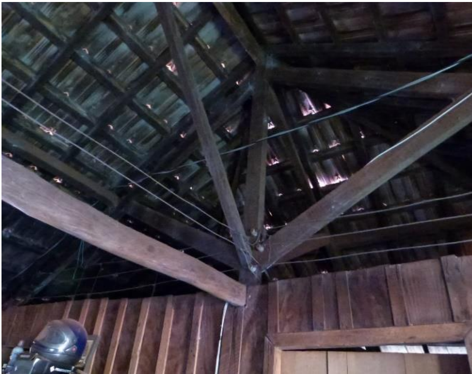
Figura 18 - Tesoura atirantada
