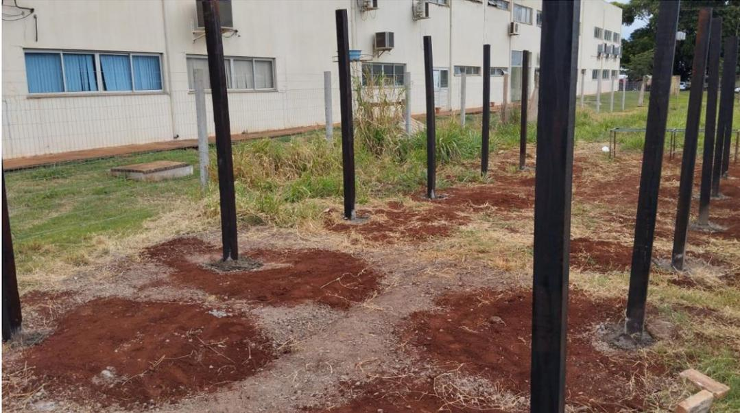
**Figura 9.** Vigas de sustentação da estufa, impermeabilizadas e alocadas em seus devidos lugares.
