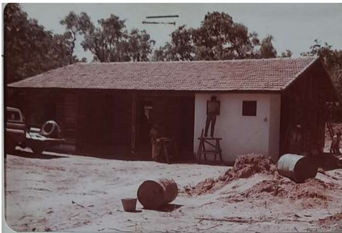
Figura 2 – Construção da Escola Estadual Padroeira do Brasil - 1985
