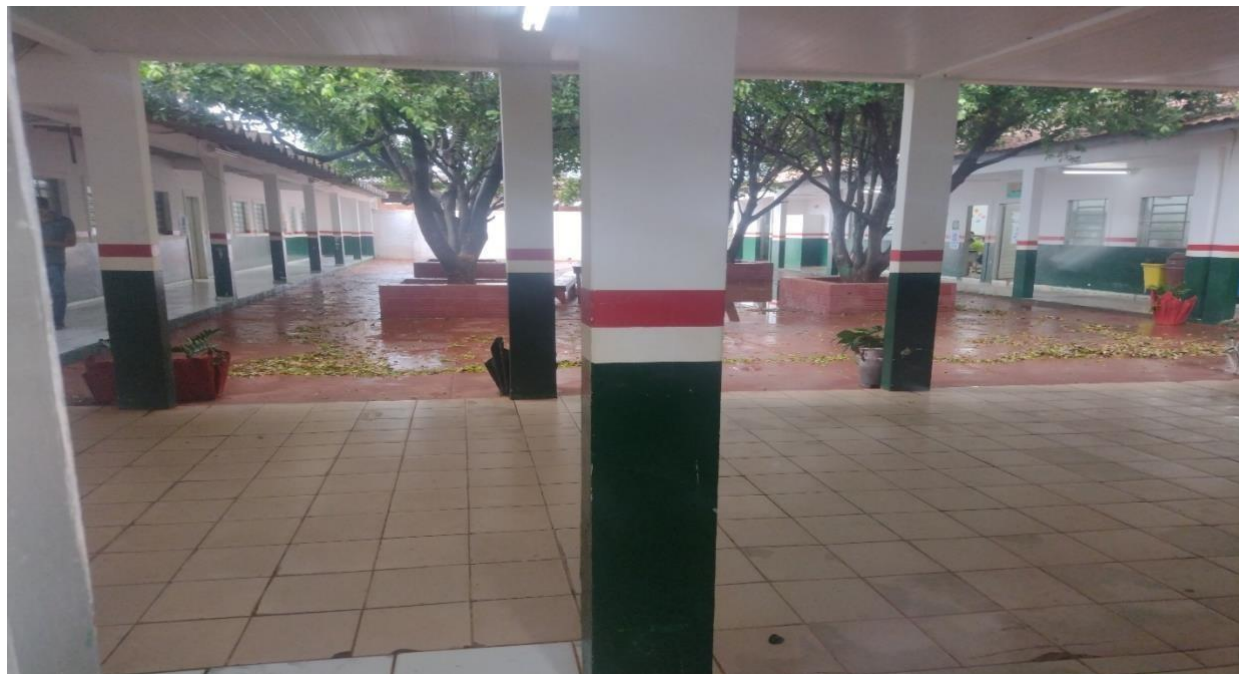
Figura 6. Pátio interno da escola Municipal Noé Nogueira.
