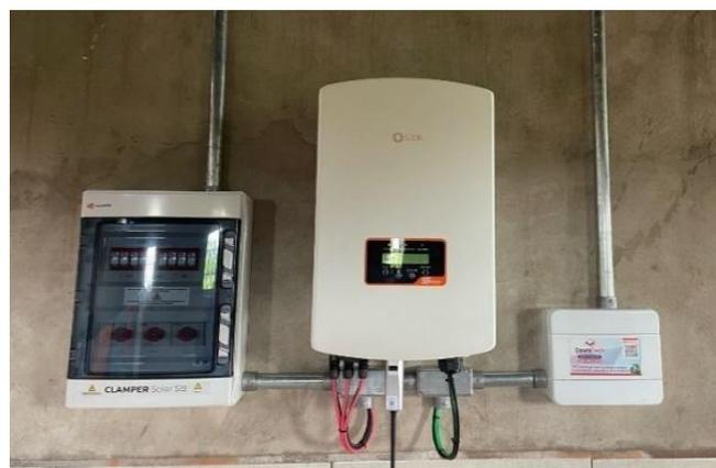
Figura 22 - Instalação da *string box* e inversor
