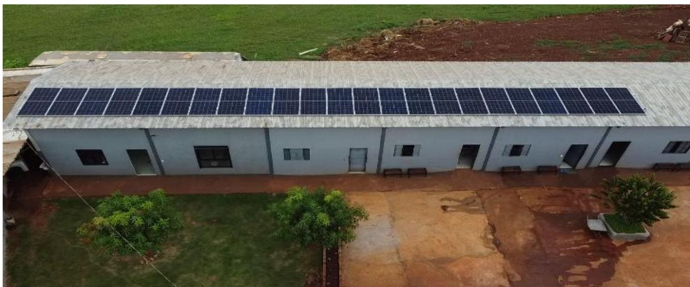
Figura 21 - Módulos instalados no telhado do prédio principal da instituição beneficente.
