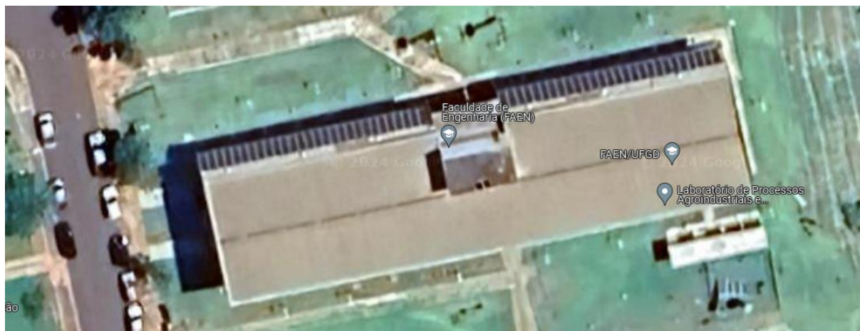
Figura 1 - Vista superior do bloco FAEN/UFGD
