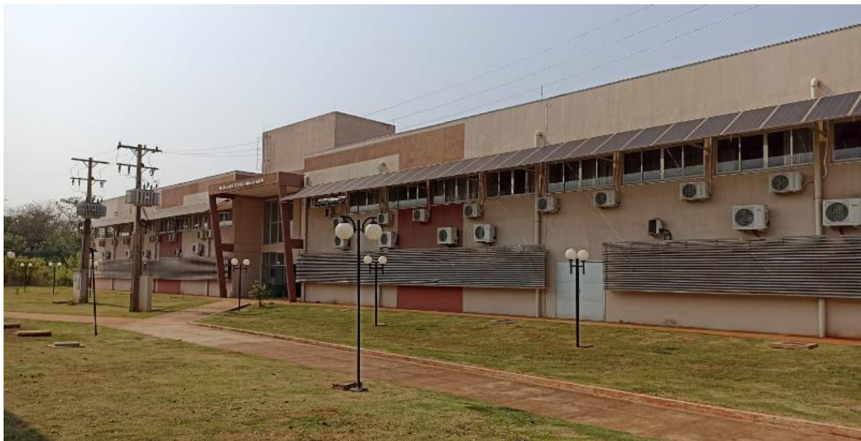
Figura 4 - Fachada norte do bloco FAEN/UFGD
