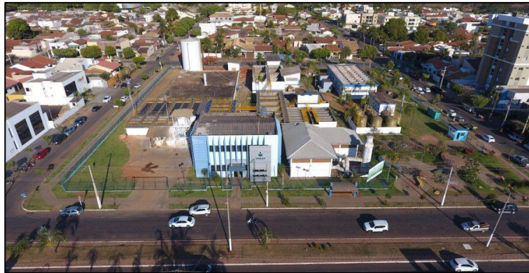
Imagem 8 – Estação de tratamento e distribuição
