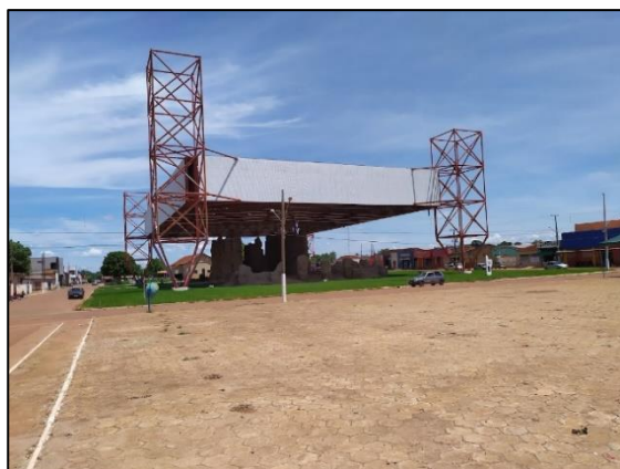
Imagem 34 – Estrutura de proteção
