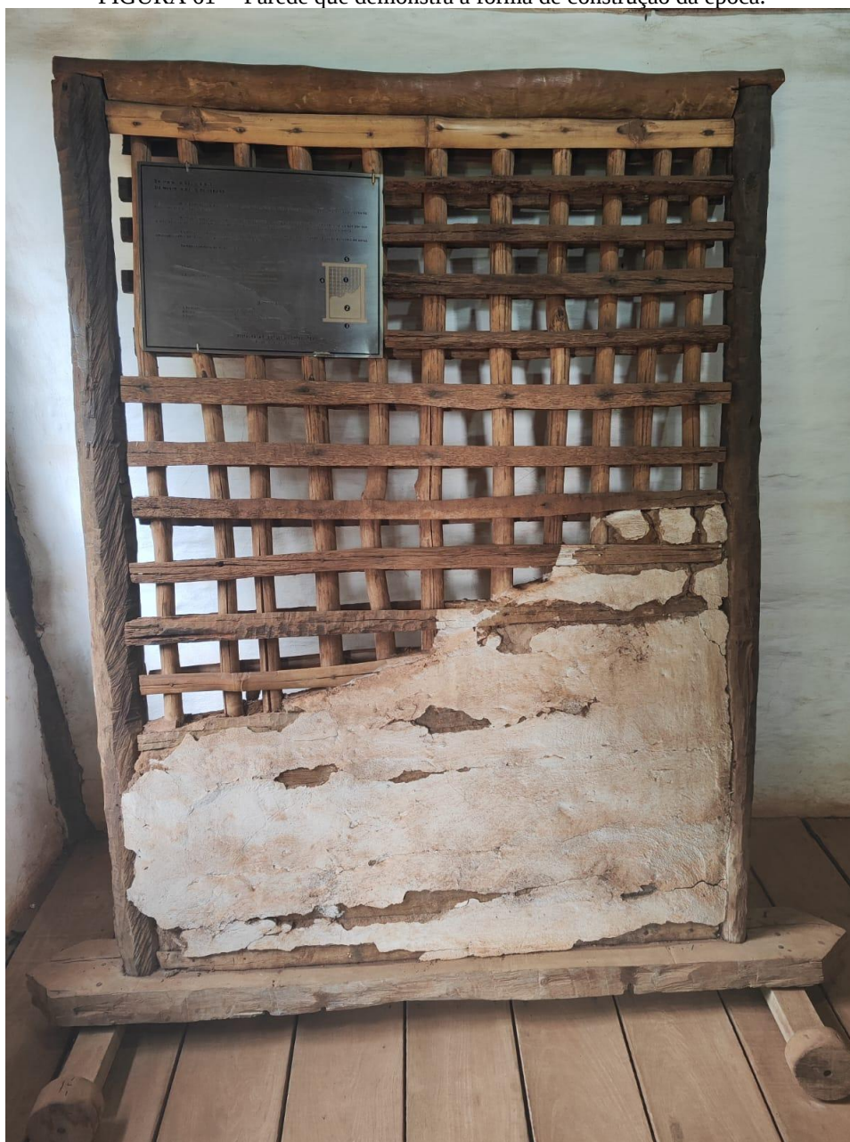
FIGURA 61- - Parede que demonstra a forma de construção da época.
