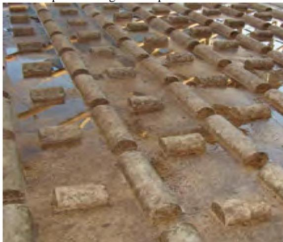
Estrutura antiderrapante com piso concretado com bloquetes
