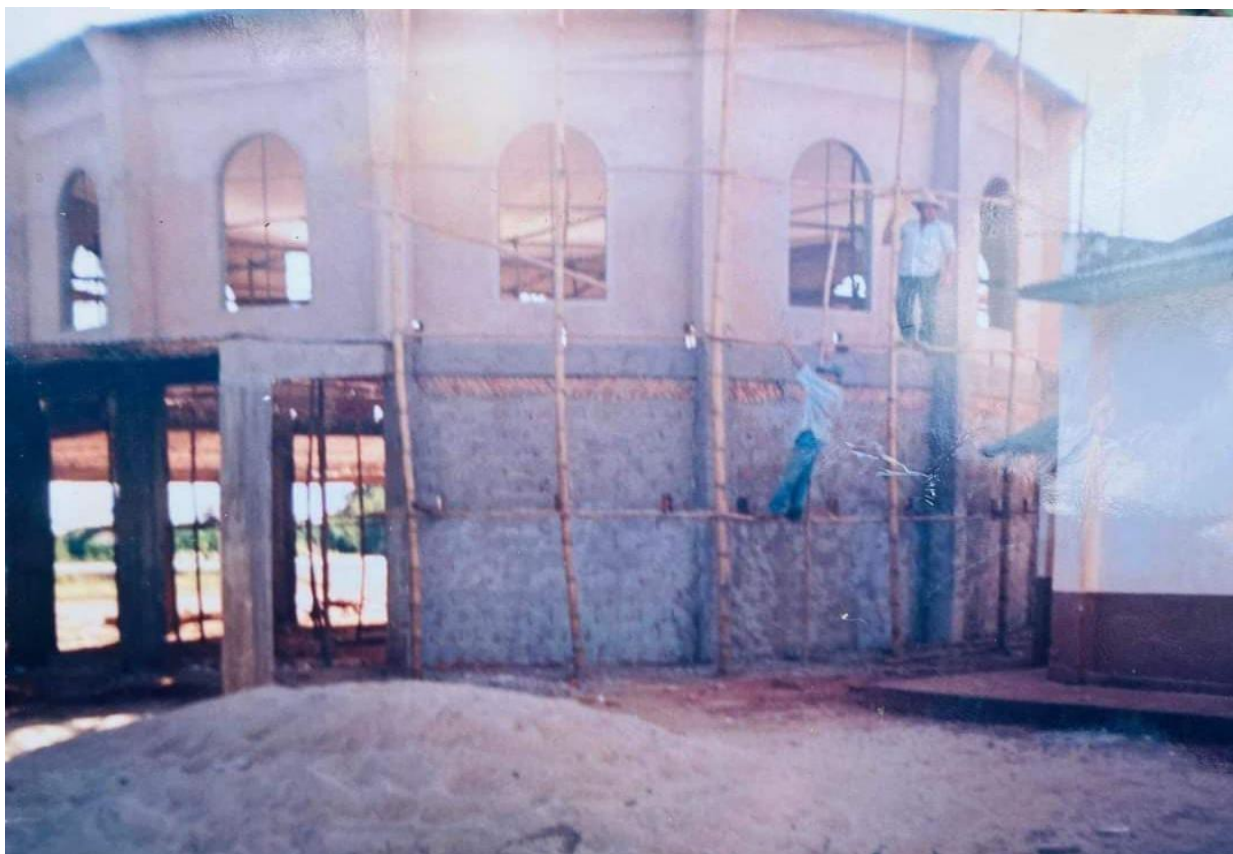
Figura 2: Obras da Igreja Nossa Senhora Aparecida.
