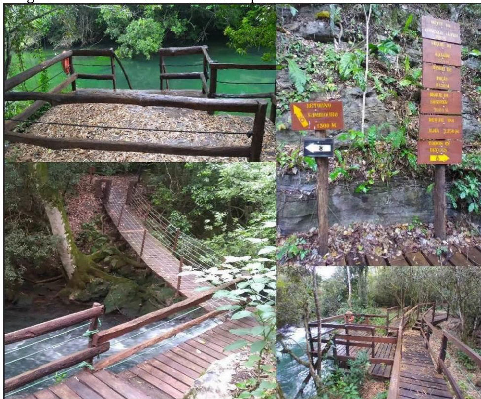
Figura 21 – Infraestrutura instalada a partir do sumidouro do Rio Perdido
