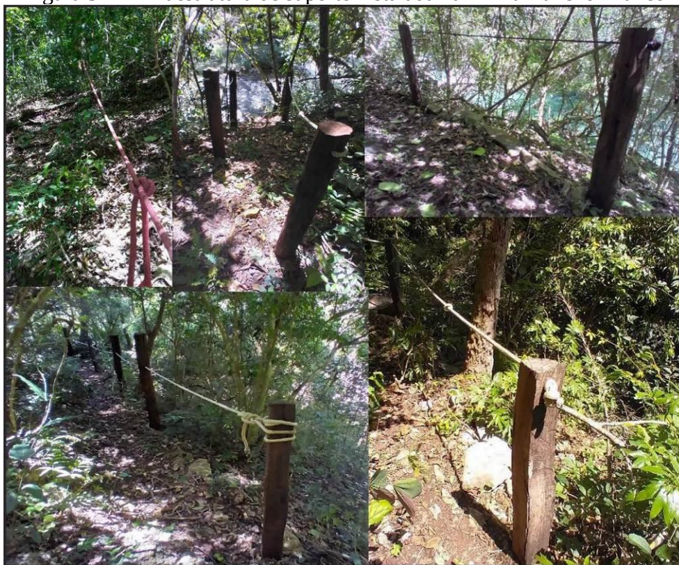
Figura 31 – Infraestrutura de suporte instalada na Trilha Rancho Branco
