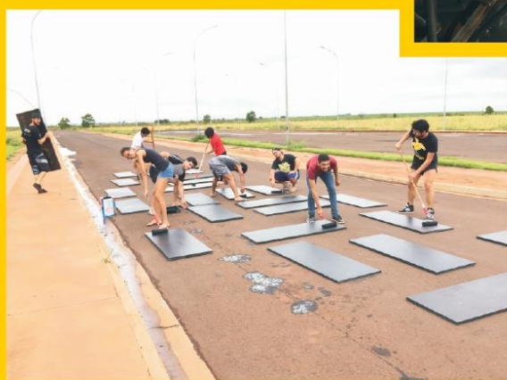
Pintura das arquibancadas para o público
