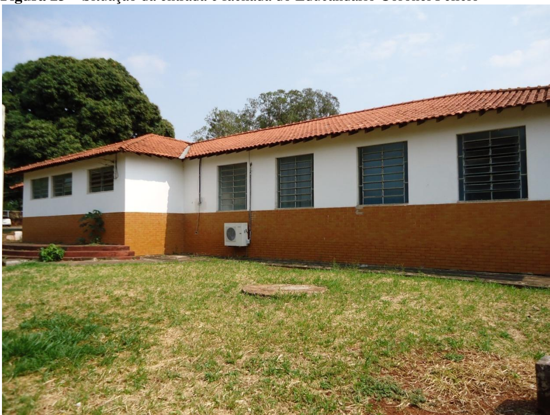
Figura 23 – Situação da entrada e fachada do Educandário Coronel Felício
