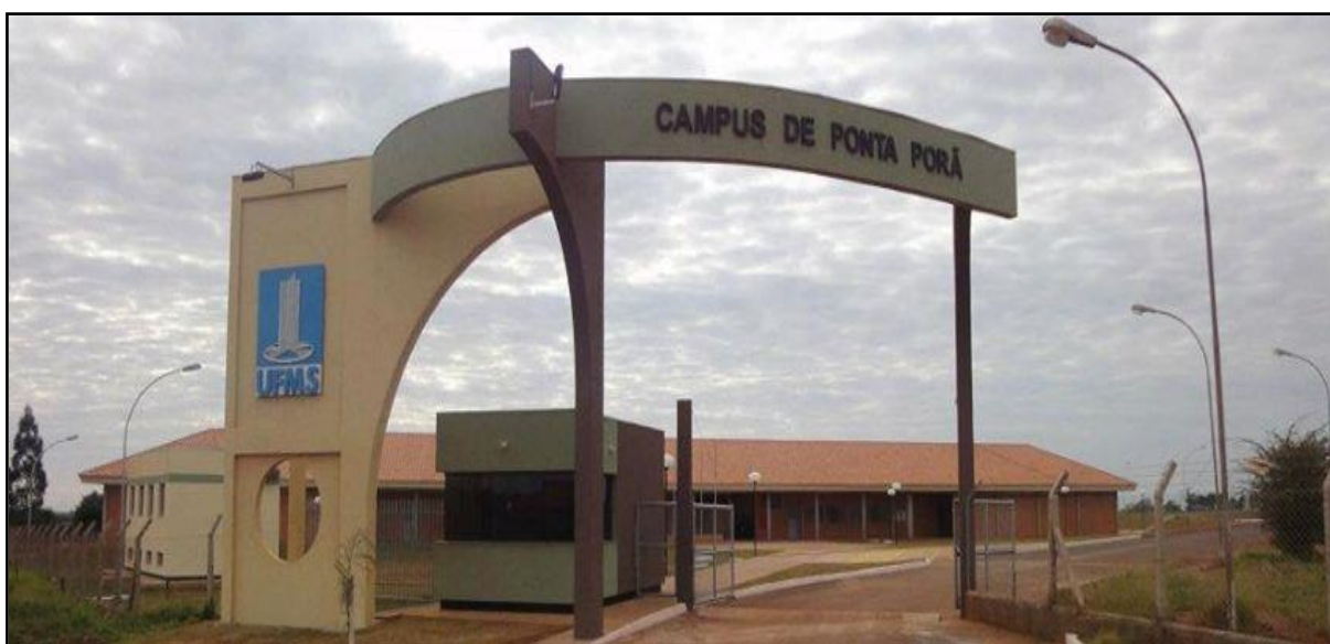
Figura 2 – A foto acima ilustra o Pórtico da entrada da UFMS em Ponta Porã, esta estrutura e o bloco que aparece logo após a entrada do campus, inaugurado em 2012, são as novas instalações nesta localidade, estão disponíveis dois prédios, o segundo que dispõem das salas de aula, não aparece claramente na imagem por estar atrás do prédio frontal, o qual abriga as instalações de secretaria, sala de professores, sala da direção, as salas das coordenações, biblioteca e outras instalações como banheiros e depósitos. À direita deste bloco, imagem que será mostrada nas páginas seguintes, está localizado o primeiro bloco da universidade, construído para a abertura do campus e que até o ano de 2016 está cedido em comodato para a Universidade Estadual de Mato Grosso do Sul (UEMS). Fonte: http://cpnv.sites.ufms.br/-04/10/2012 .
