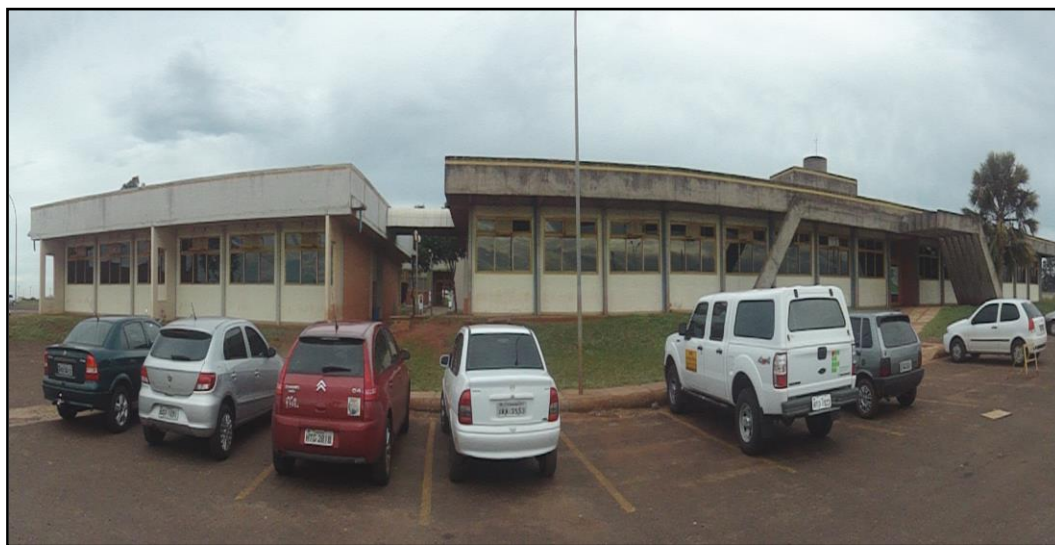
FIGURA 5 – Foto do Bloco I da UFMS em Ponta Porã.
