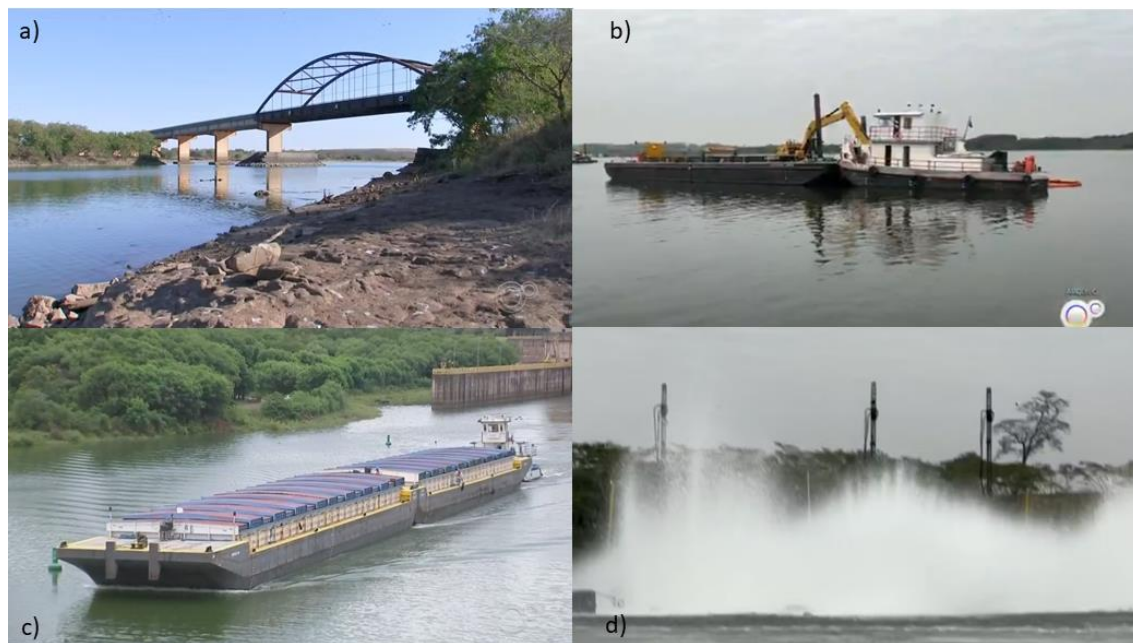
Figura 74 - Obras de aprofundamento no canal de Avanhandava, em Buritama (SP).
