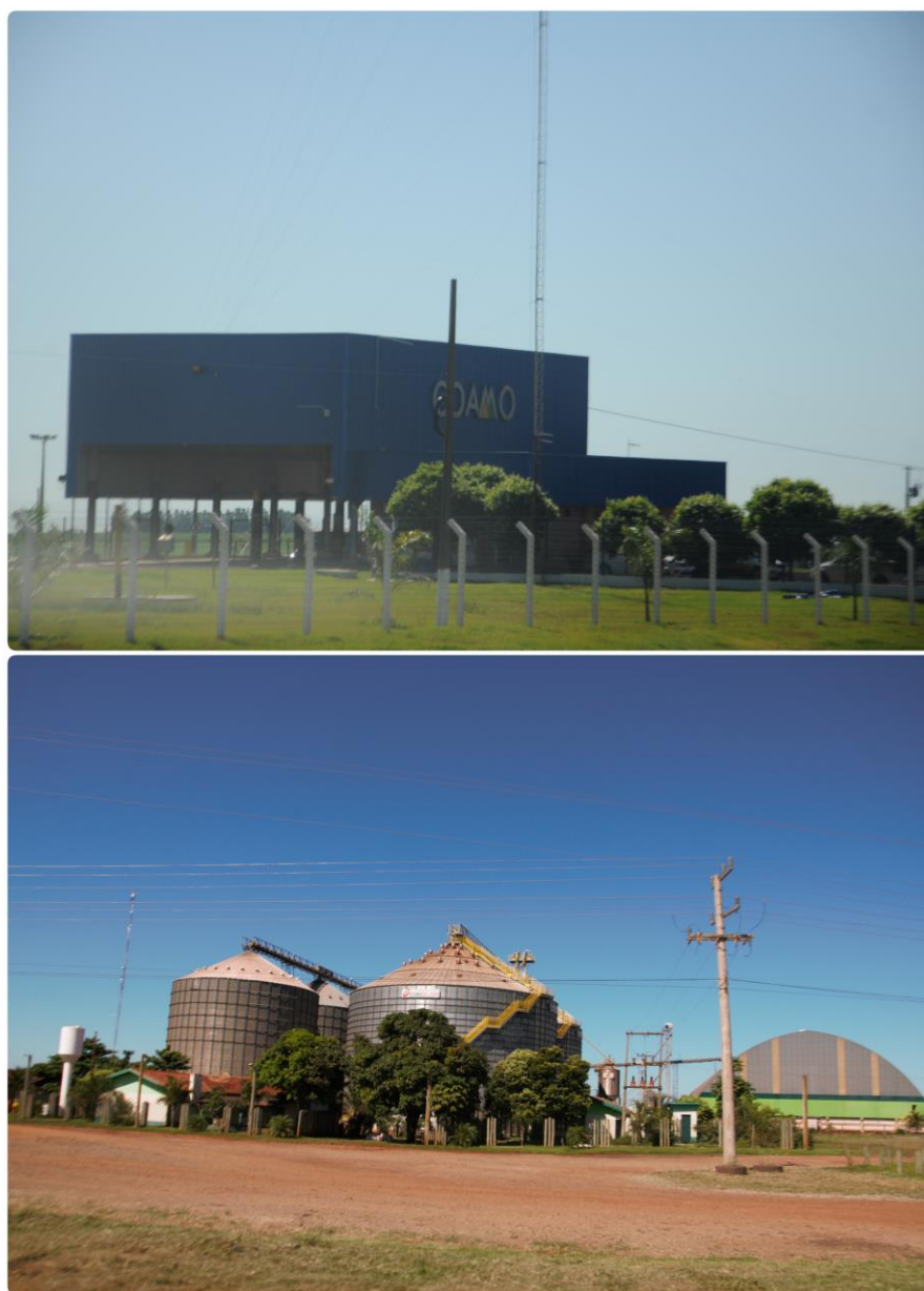
Figura 26 - Estrutura Coamo entre Guia Lopes da Laguna e Maracaju, na BR-267
