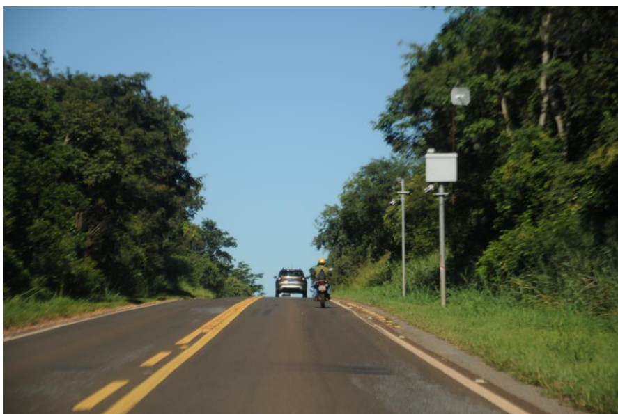
Figura 98 - Radar de controle de velocidade rodovia BR-060 Guia Lopes da Laguna
