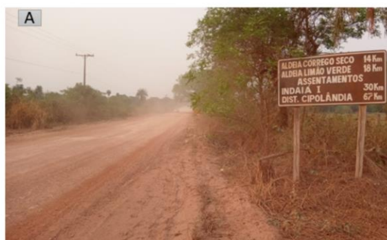
MS-477 Sem massa asfáltica Sentido Aquidauana (sede) - Distrito de Cipolândia (Foto: O próprio Autor, 2024)
