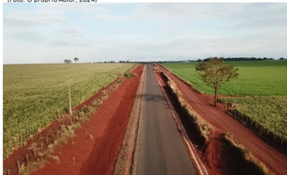
Pavimentação do trecho da Ponte do Grego (MS-352) a sede do município de Terenos (BR-262) (Foto: AGESUL, 2023)
