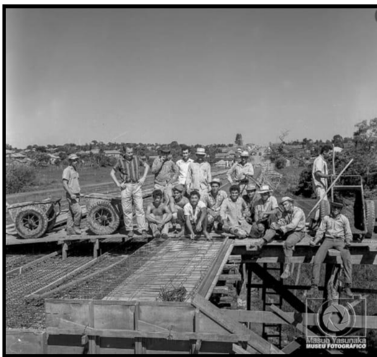
Fotografia 23: Trabalhadores na construção da ponte sobre o rio Dourados, em 1965
