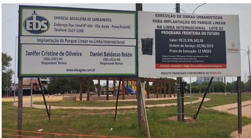
Figura 11 Placa de Execução de Trecho da Obra do Programa Fronteira do Futuro
