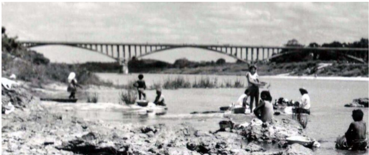
Figura 8 - Imagem da ponte Juscelino Kubitschek.
