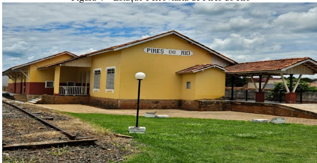
Figura 4 – Estação Ferroviária de Pires do Rio
