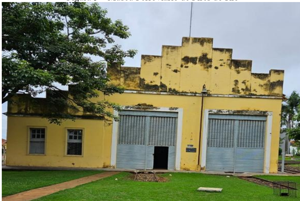
Figura 5 – Museu Ferroviário de Pires do Rio
