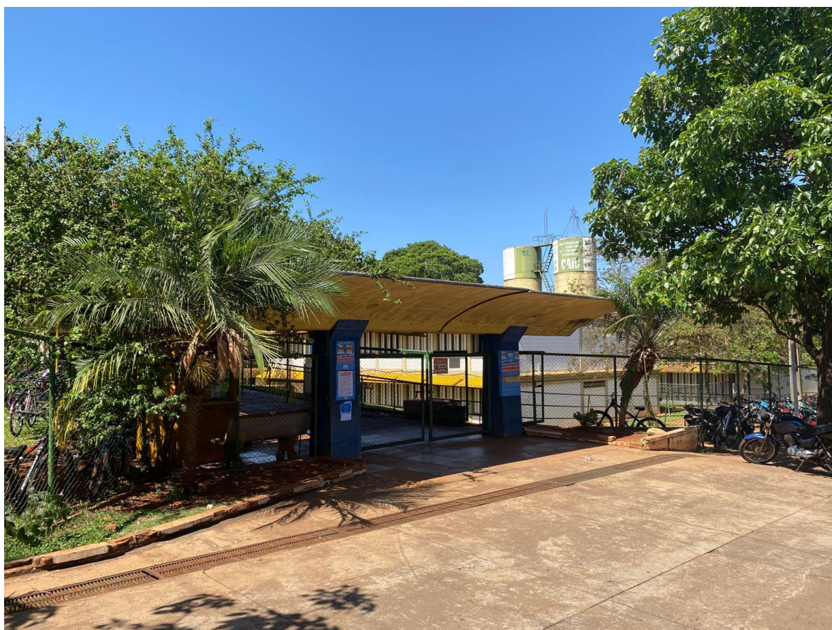
Figura 20 - Fachada da Escola Municipal Neil Fioravanti – CAIC
