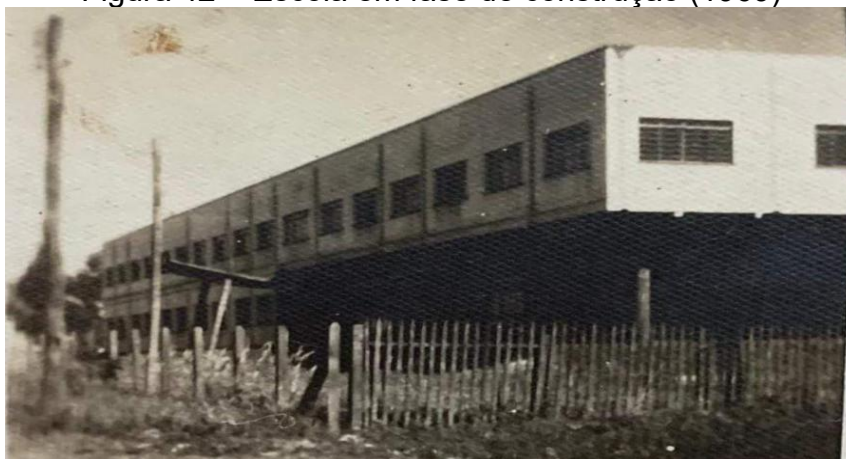
Figura 42 – Escola em fase de construção (1969)
