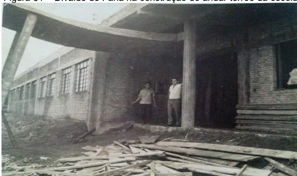
Figura 51 – Divaldo de Faria na construção do andar térreo da escola
