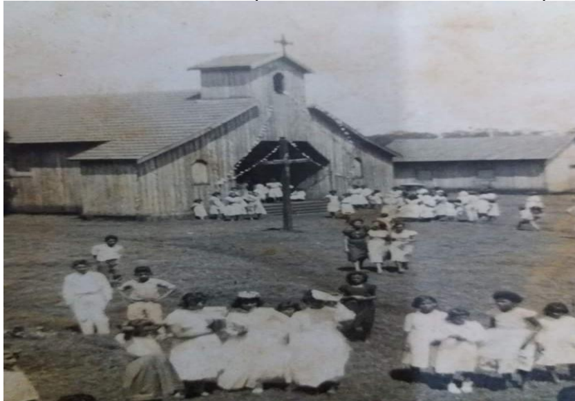
Figura 36 – Escola Rainha dos Apóstolos ao lado direito da capela (1958)
