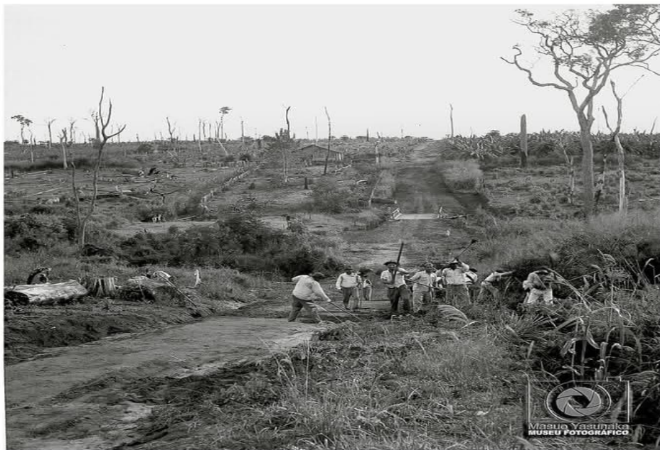
Figura 24 – Abertura da estrada entre Vicentina e Fátima do Sul entre 1950 e 1953
