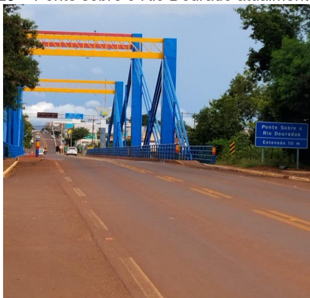
Figura 23 – Ponte sobre o Rio Dourado atualmente (2026)
