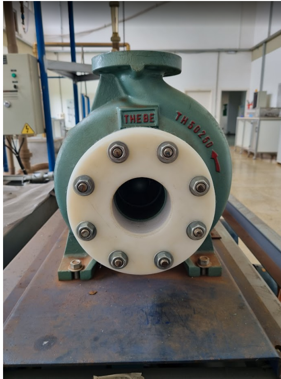
Figura 40 – Bucha de nylon com vedação de borracha instalada na sucção da BFB para conexão com a tubulação.
