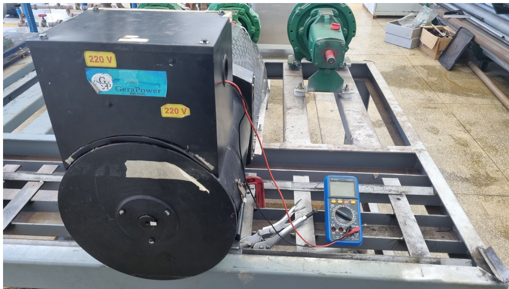
Figura 54 – Medição da tensão elétrica em vazio nos terminais do alternador.
