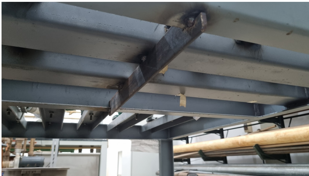
Figura 66 – Reforço estrutural implementado na região do trilho do alternador.
