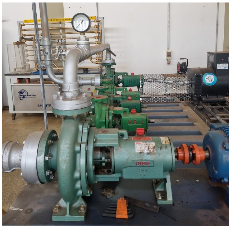
Figura 44 – Montagem do circuito hidráulico de teste instalado na bancada experimental.
