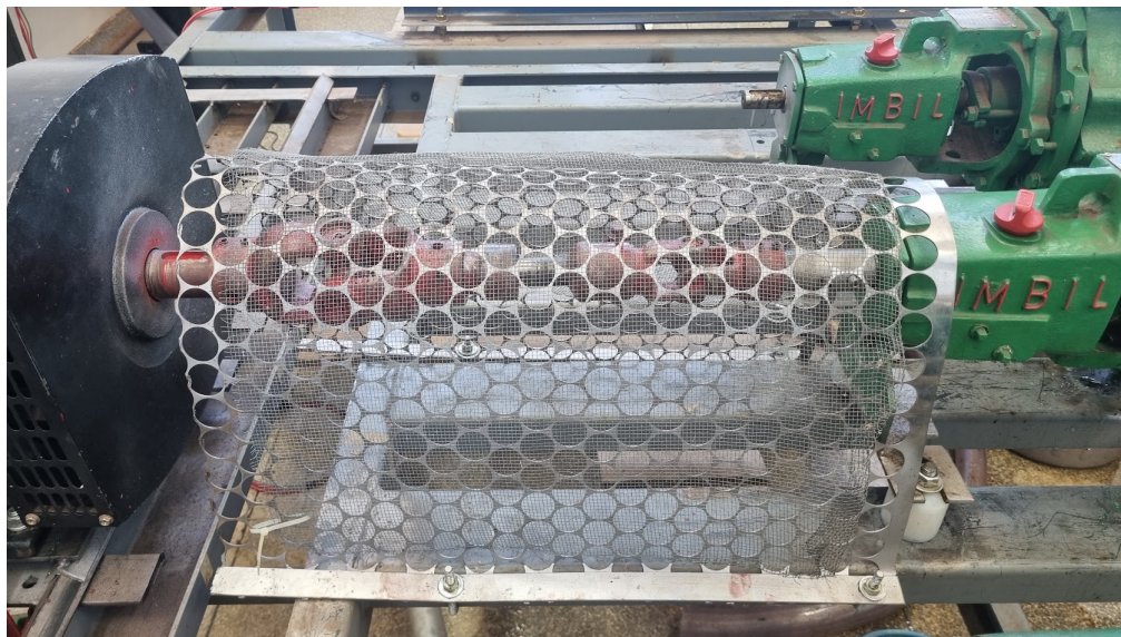
Figura 50 – Proteção metálica instalada na região de acoplamento entre a BFT e o alternador.
