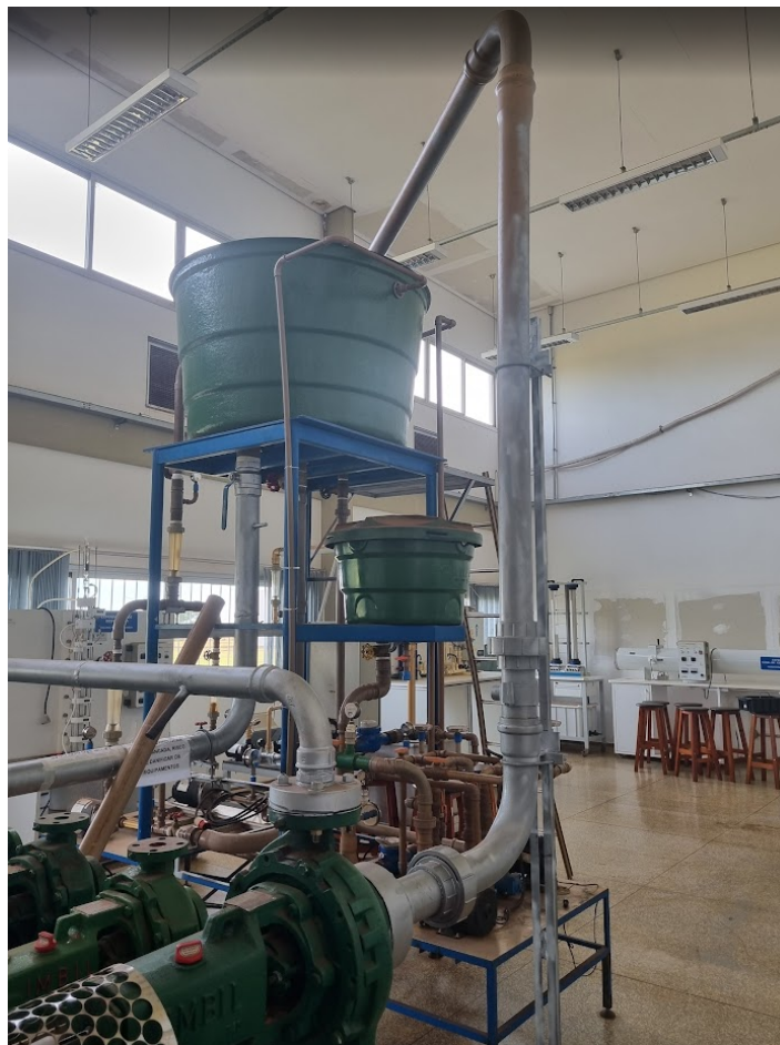
Figura 43 – Sistema de retorno da água da BFT para o reservatório.
