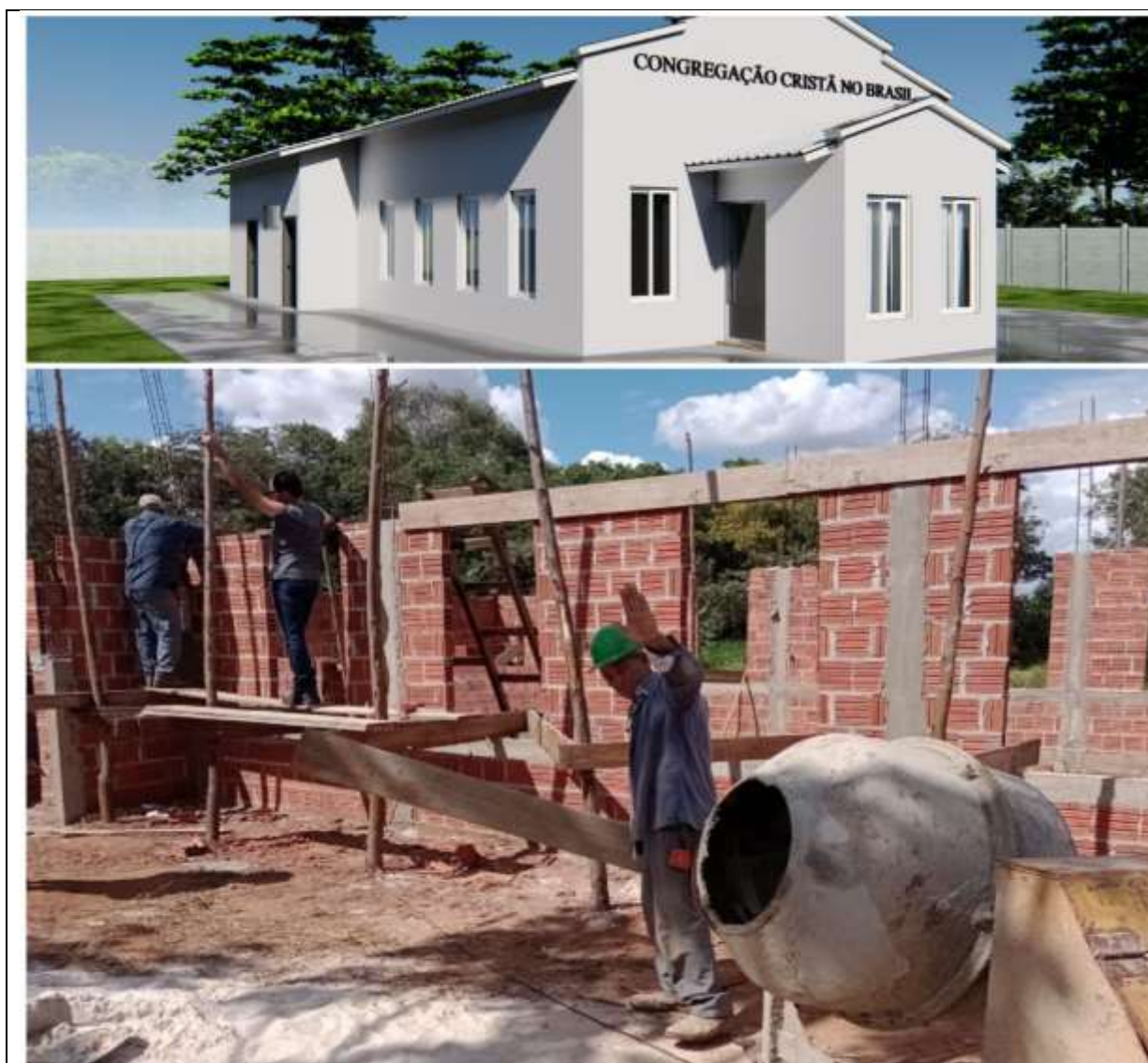
Processo de construção evidenciando a agência dos próprios adeptos, que atuam como pedreiros na construção do templo.
