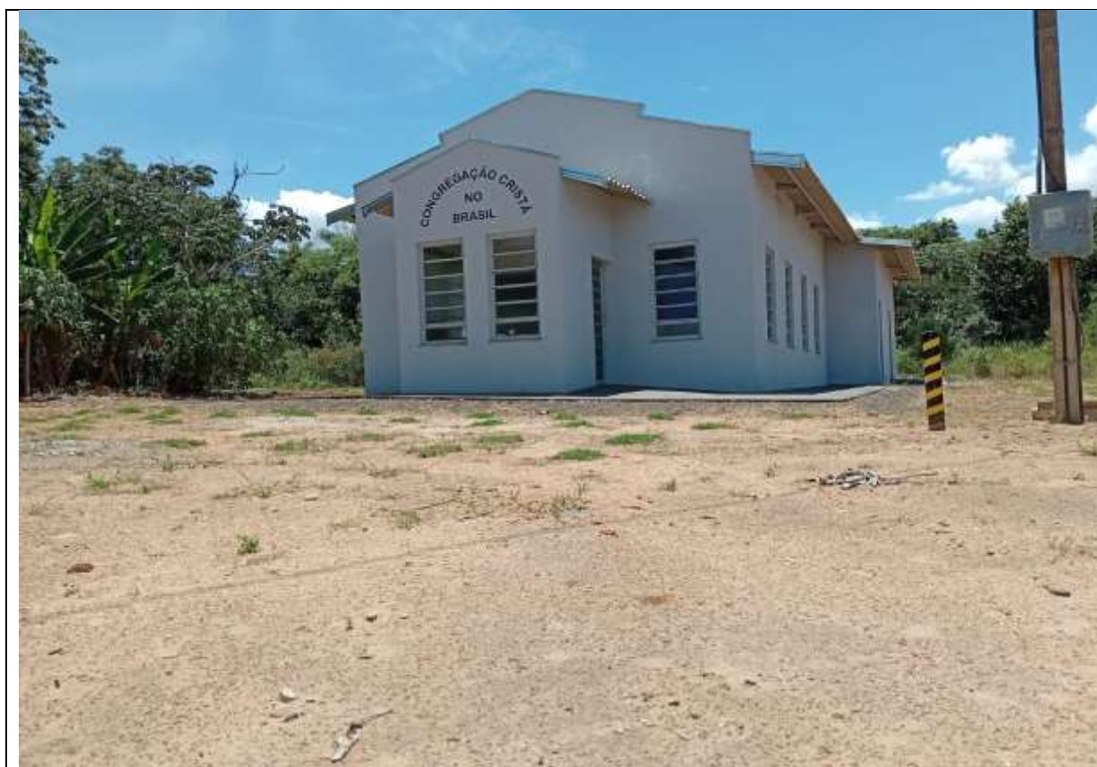
Templo da Congregação Cristã no Brasil finalizado após meses de trabalho coletivo na área central da reserva.
