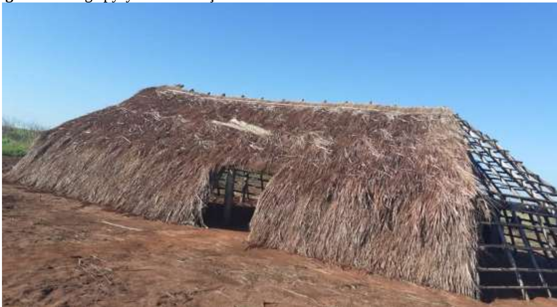
Figura 33 – Óga pysy em construção
