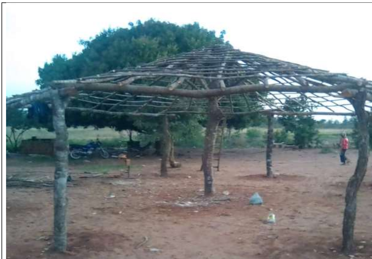
Estrutura provisória de madeira e sapé, evidenciando o uso de materiais locais no início do processo de territorialização da igreja.
