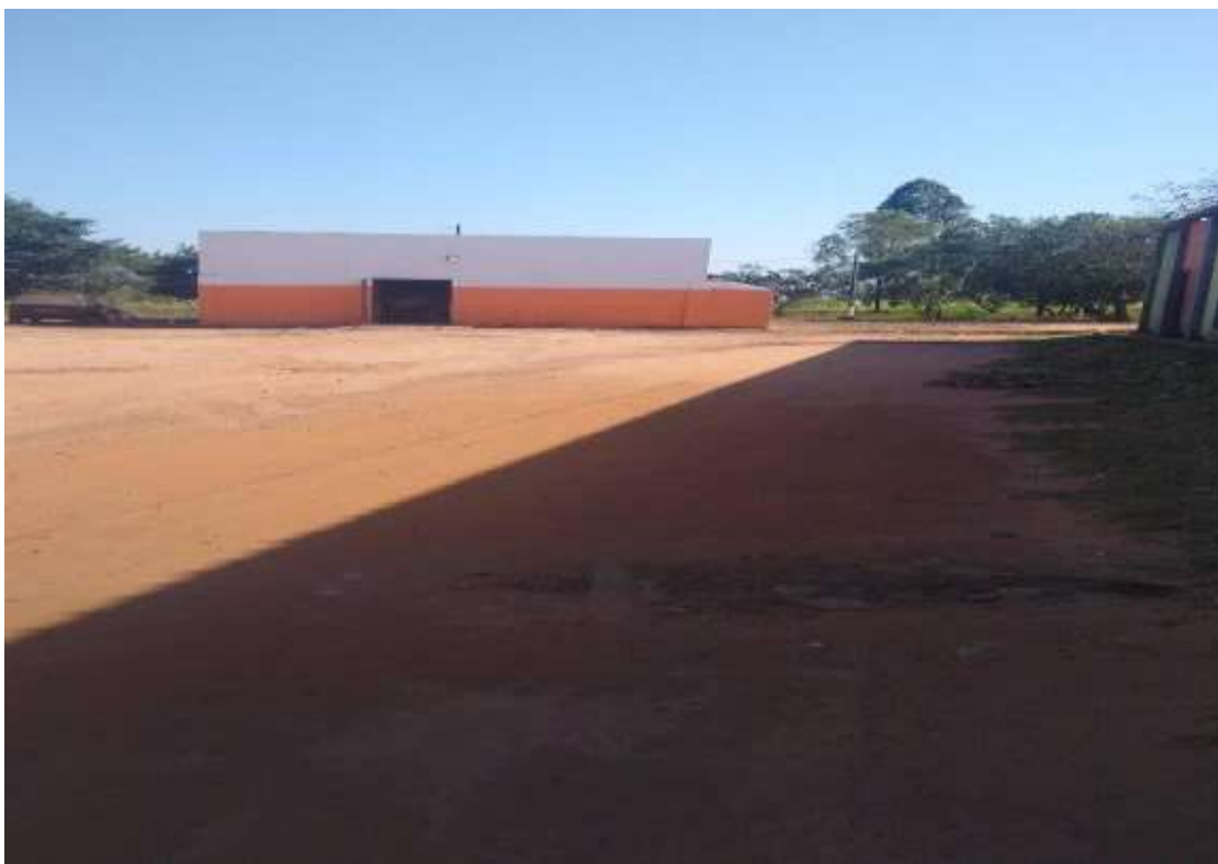
Figura 28 – A segunda edificação da denominação, construída ao lado do templo antigo
