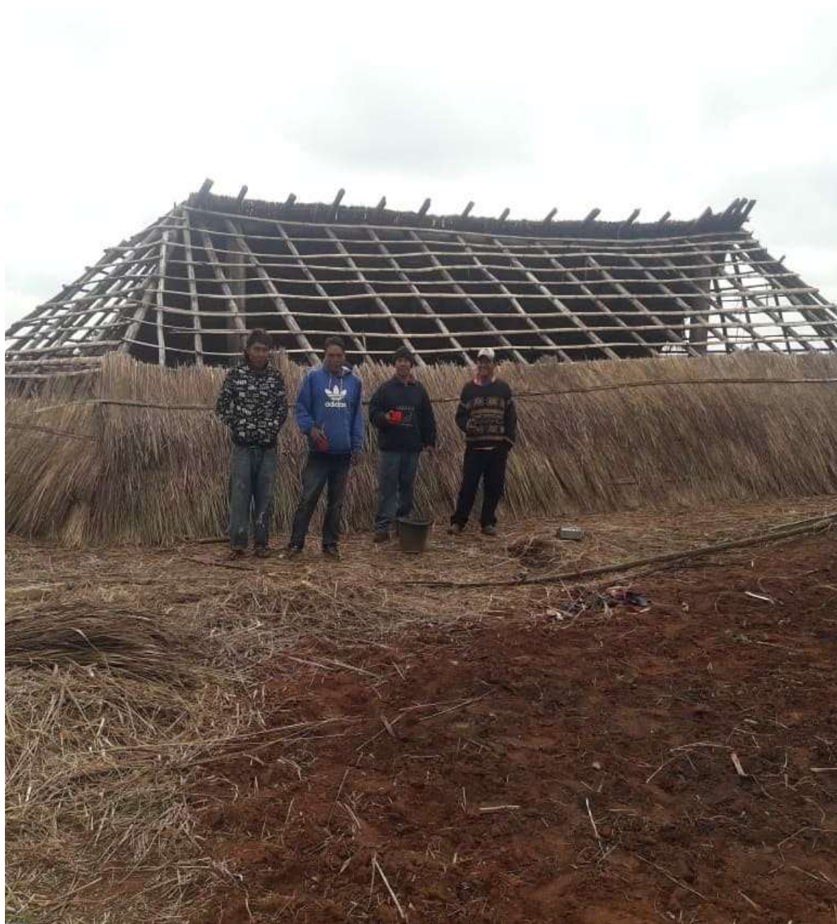
Figura 52 - Estrutura da casa de reza em fase final
