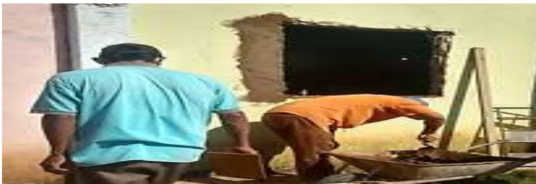
Figura 30 – Processo de construção do terceiro e atual templo da Igreja Pentecostal Deus é Amor
