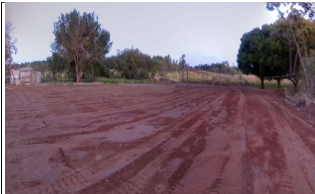
Preparação do terreno na Região Centro para o início das construções da nova igreja.
