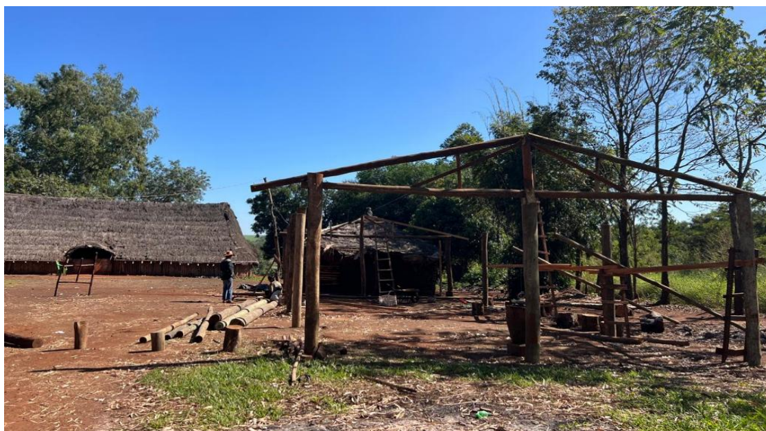
Figura 4 – Escola da Ñandesy Dona Floriza, ao fundo a casa de reza e a escola antiga, à frente a estrutura da nova escola sendo levantada.
