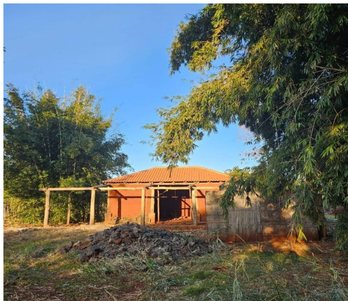
Figura 8 - Estúdio ecológico Futuro estúdio ecológico do grupo, ainda em fase de construção.
