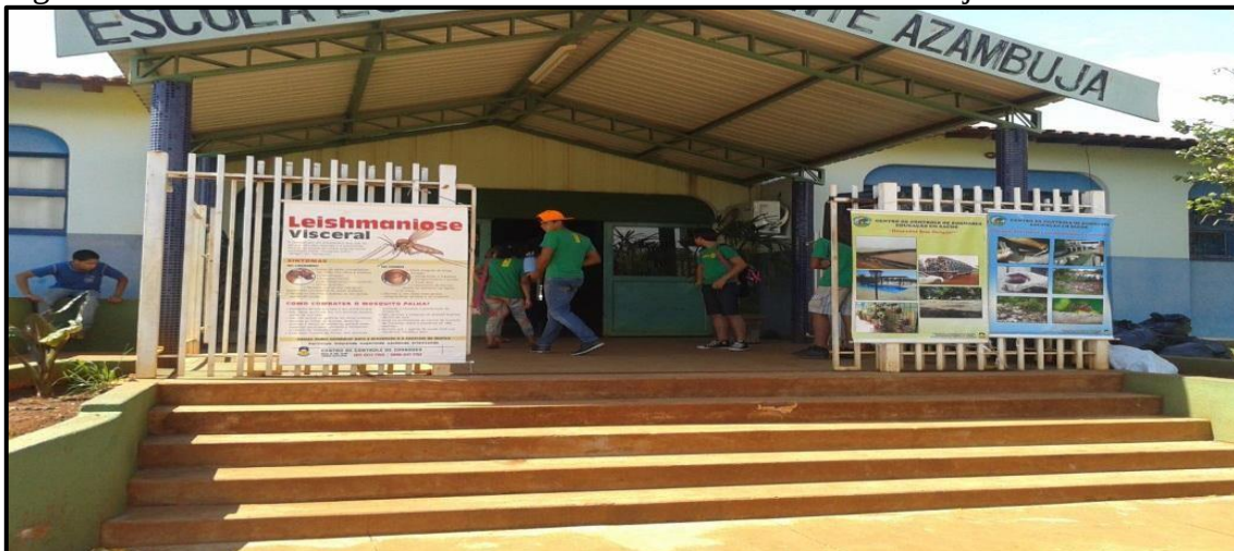
Figura 6 - Vista frontal da Escola Estadual Antônio Vicente Azambuja – 2019
