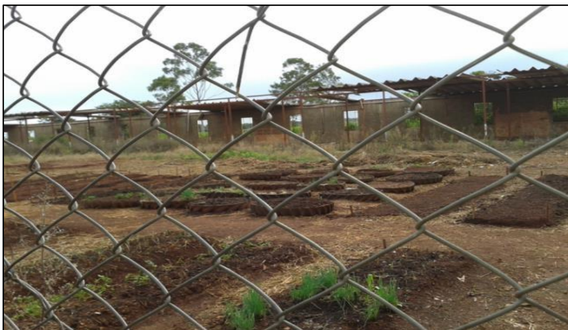
Figura 15: Espaço Interno da EE Nova Itamarati – antiga casa de máquinas
