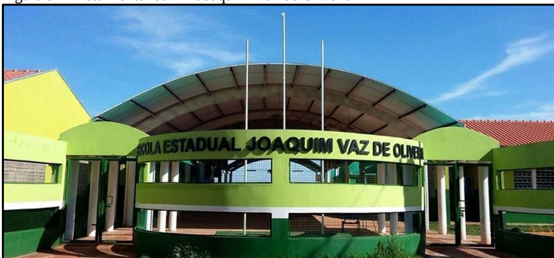
Figura 9 – Vista frontal da EE Joaquim Vaz de Oliveira
