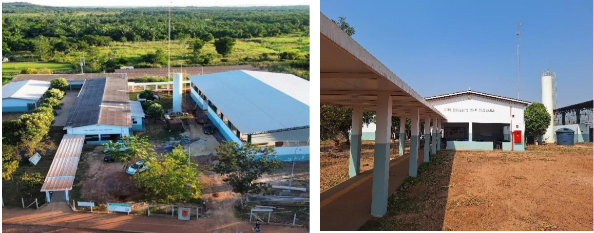
5d e 5e- Situação Atual Da Escola Ernesto Che Guevara. Fonte: SEMEC Tangará da Serra.
