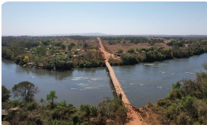
FIGURA 2. Ponte sobre o Rio Sepotuba, Assentamento Antônio Conselheiro
