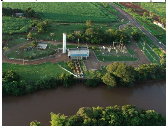
Captação de água bruta rio Dourados Dourados, 2022
