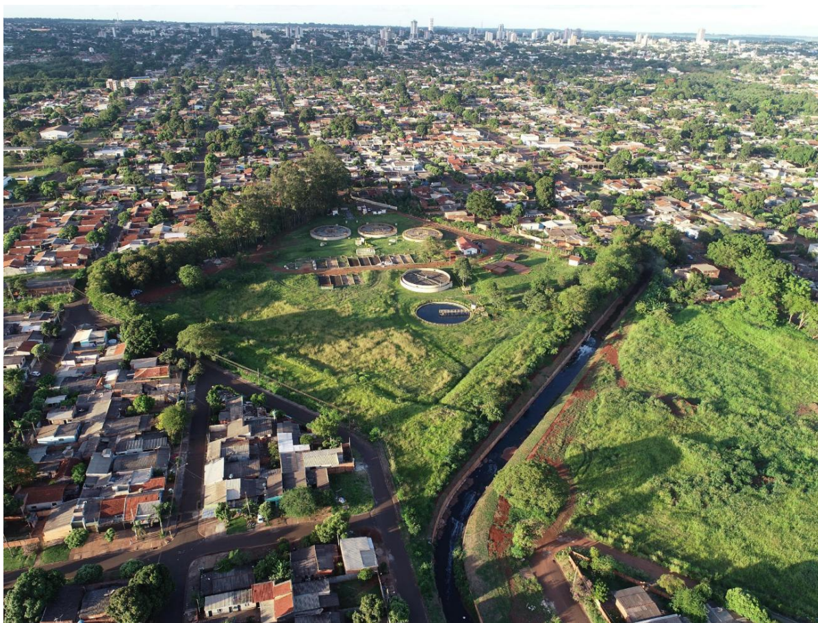
Figura 61 - Estação de Tratamento de Esgoto (ETE) Guaxinim às margens do córrego Rego D'água com parte da sua área de contribuição no contexto urbano de Dourados/MS.
