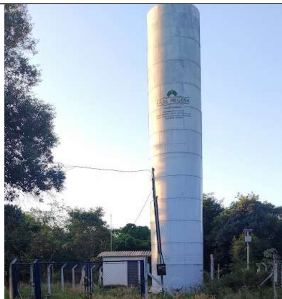
Captação de água subterrânea – Aldeia Te'yikue - Caarapó, 2022
