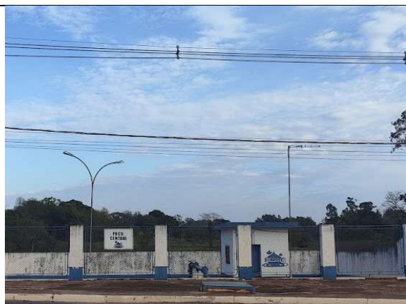
Captação de água subterrânea - DMAE Glória de Dourados, 2023
