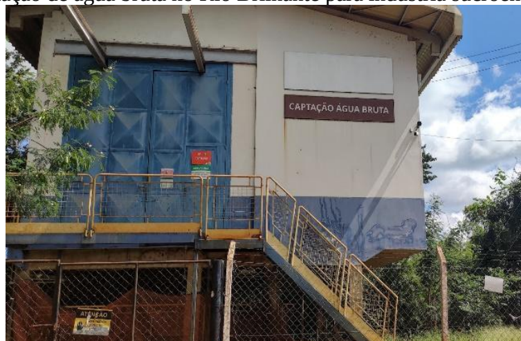
Figura 24 - Captação de água bruta no Rio Brilhante para indústria sucroenergética
