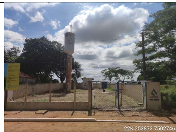
Captação de água subterrânea - SANESUL (Vila São João) Taquarussu, 2023
