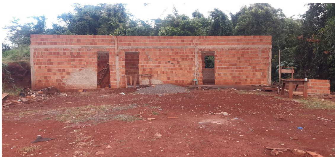
Imagem 25: Construção das primeiras salas.
