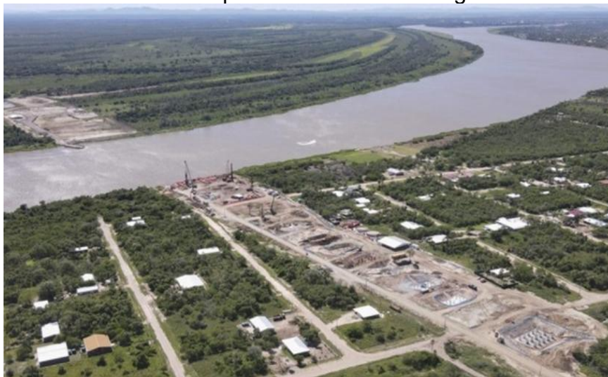
Figura 1: Início das obras da ponte sobre o Rio Paraguai em Porto Murtinho
