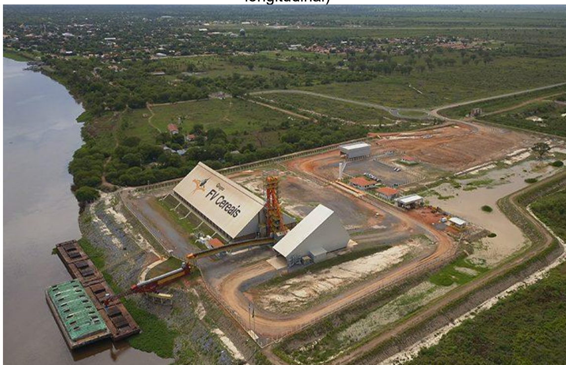
Figura 6: Terminal hidroviário de Porto Murtinho-MS em fase de construção (vista longitudinal)
