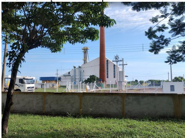
Figura 19: Observação da área portuária ao fundo da escola
