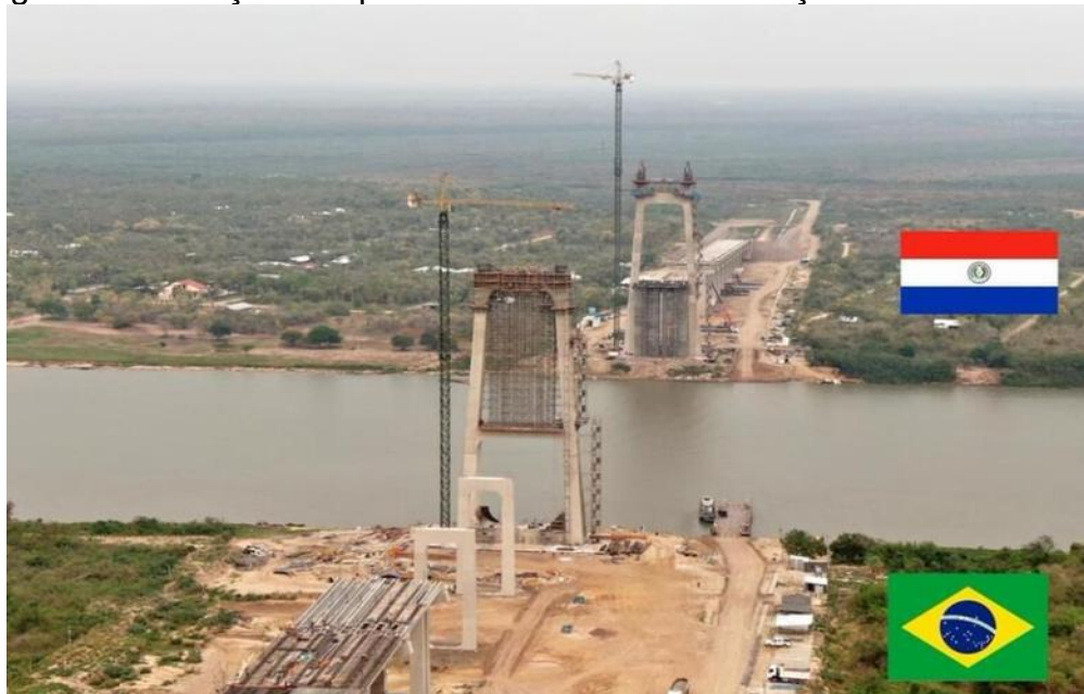
Figura 4: Fundações da ponte binacional em construção no lado brasileiro
