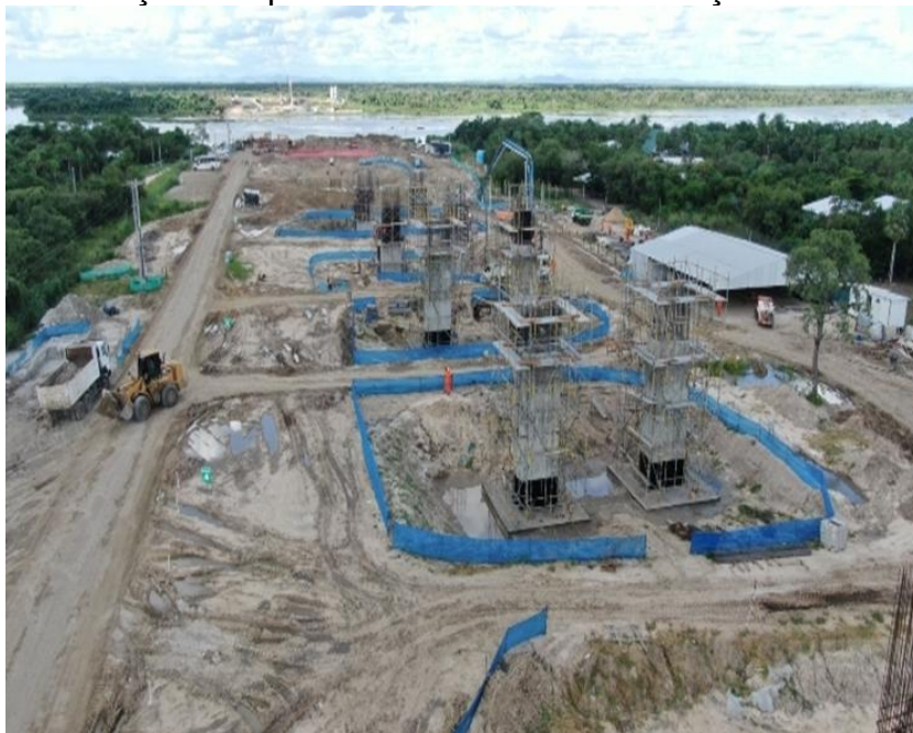
Figura 3: Fundações da ponte binacional em construção no lado brasileiro
