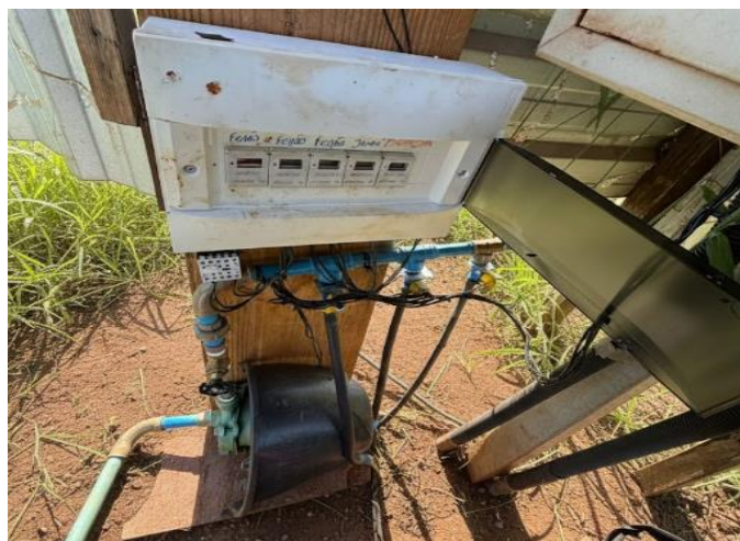
Figura 11. Cabeçal de controle equipado com temporizador e válvula solenóide do sistema de irrigação.
